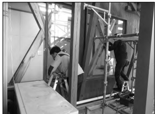
写真 6 会議室前の窓のアルミサッシ 工事 (2023 年 3 月 3 日)
