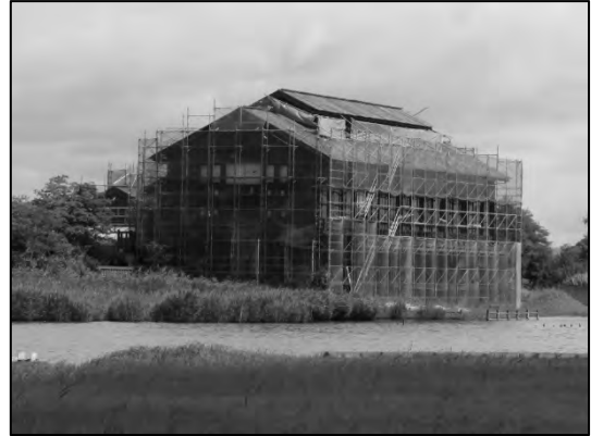
写真 2 ネイチャーセンター外壁の塗装 (2022 年 7 月 22 日)
