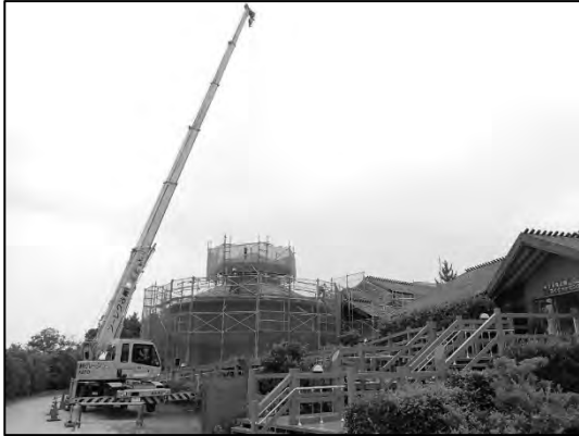
写真 1 展示室屋根の修繕 (2022 年 7 月 21 日)
