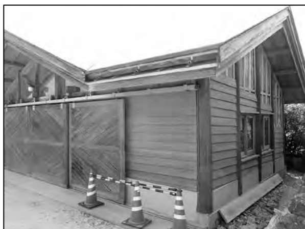
写真7 屋外倉庫外壁の修繕 (2022年5月22日)
