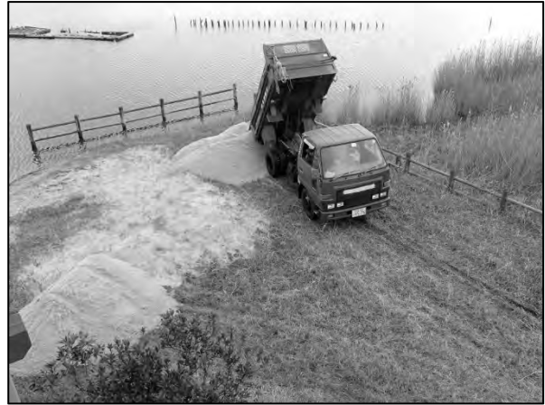
写真 12 ネイチャーセンター前の岸辺を埋め戻すための砂を搬入(2023年1月10日)
