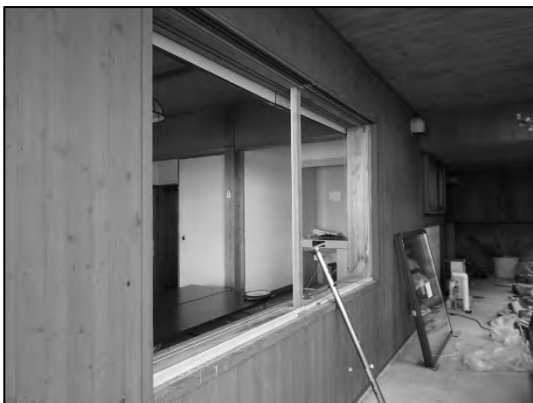
写真 3 宿直室の窓をアルミサッシに交換 (2022 年 11 月 29 日)
