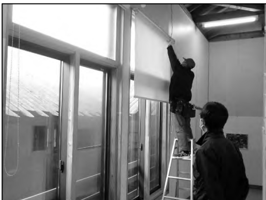
写真 5 スロープ窓のロールカーテンの 修繕 (2023 年 1 月 17 日)
