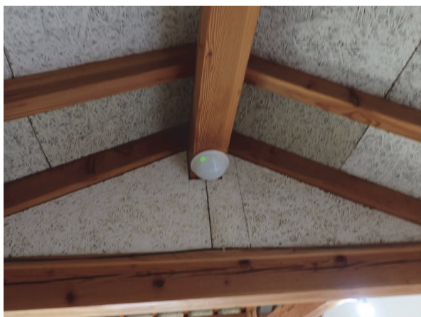
写真5 警備システムのパッシブセンサー交換 (2025年1月27日)
