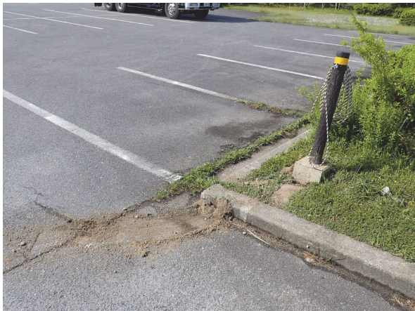
写真6 損壊された第1駐車場の支柱 (2024年5月17日)
