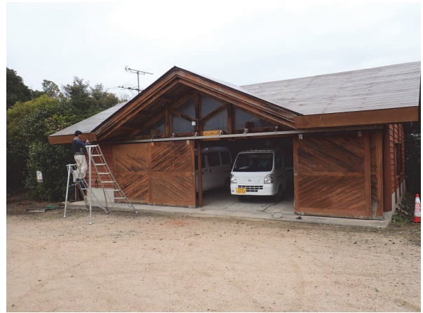
写真2 屋外倉庫屋根に破風板を設置 (2024年4月8日)
