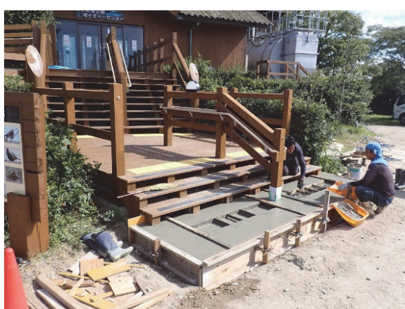
写真6 ネイチャーセンター正面入口前の階段 修理(2023年10月4日)
