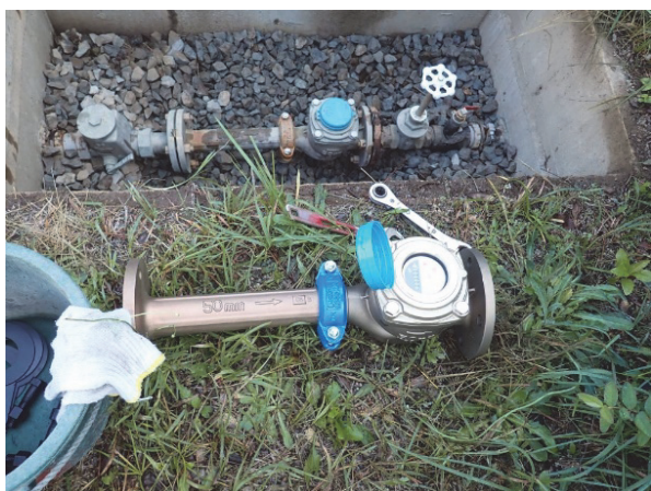
写真5 水道メーターの交換 (2023年9月29日)
