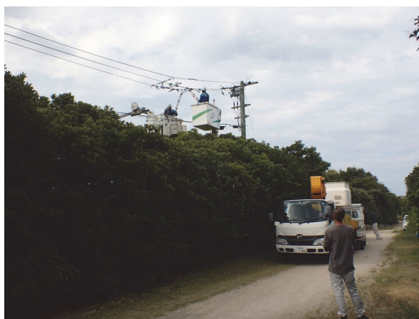
写真4 キュービクルに繋がる電線の開閉器 交換工事(2023年8月8日)
